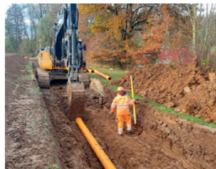
Pose de la conduite EU Vulliens Syens.
