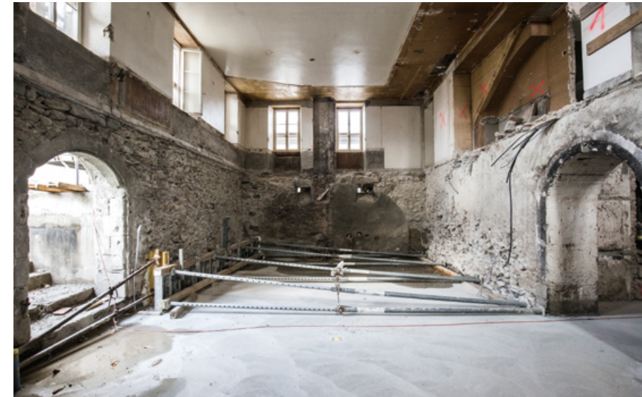
Sous-sol côté sud
