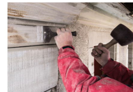
Travaux sur molasse
