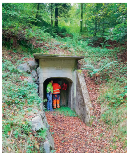
Vérification d'un captage de source en forêt à Mézières
