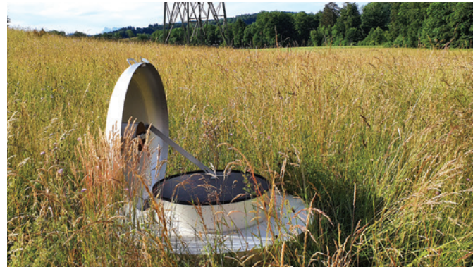
Chambre de captage source Tavanasse à Servion
