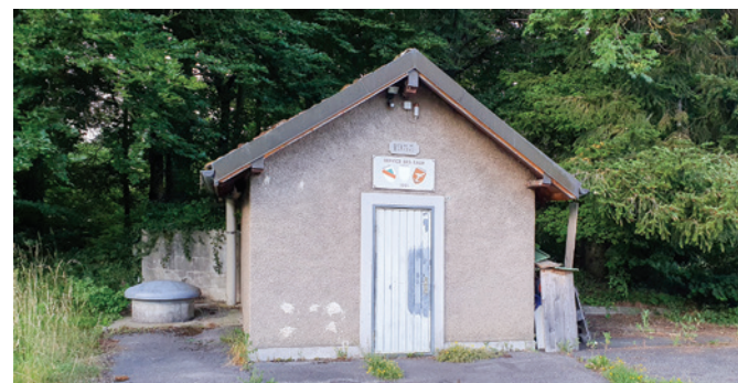
Stations de pompage des Cullayes et de Servion
