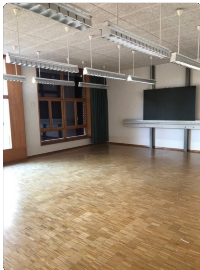
Salle de classe avant travaux
