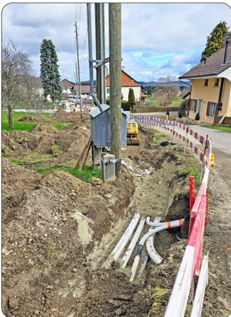
La Romande Energie a décidé de remplacer le vieux transformateur et d'enterrer les lignes aériennes de la route du Village, dans le but de renforcer le réseau. Cela doit permettre la circulation de l'électricité dans les deux sens afin de mieux intégrer la production d'électricité à partir d'énergie renouvelable.
