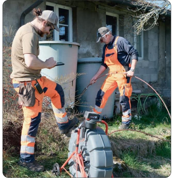
La vérification de notre réseau est aussi effectuée par des contrôles caméra qui permettent de visualiser l'intérieur des canalisations.
