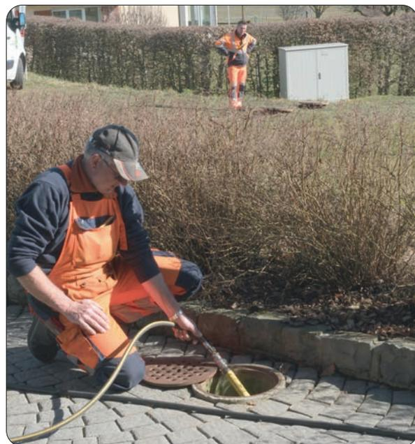
Contrôle de toutes nos canalisations par coloration pour vérifier que le réseau est correct et qu'il n'y a aucun croisement entre les eaux claires et usées.
