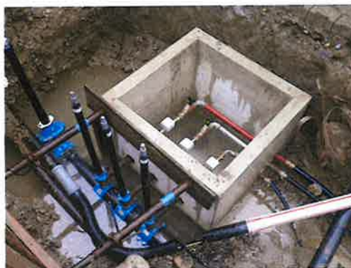
Chambre avec compteurs privés et la vanne en attente pour la liaison avec le réseau du Borgeau
